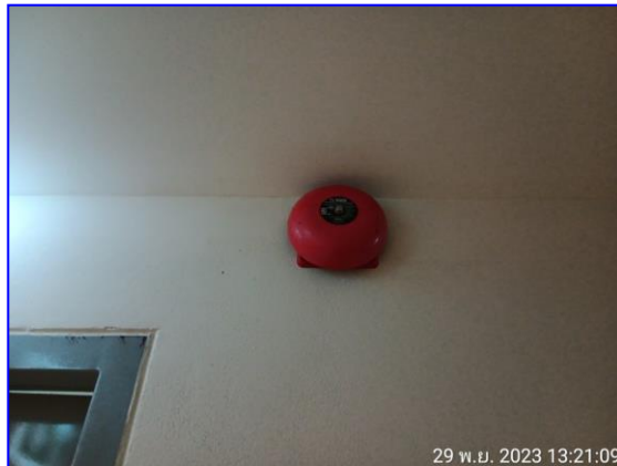
รูปที่ 2.44 สัญญาณแจ้งเตือนเหตุเพลิงไหม้
