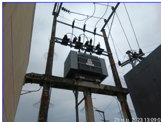
รูป 2.21 หม้อแปลงไฟฟ้า
