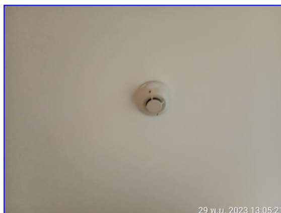
รูปที่ 2.46 อุปกรณ์ตรวจจับควัน
