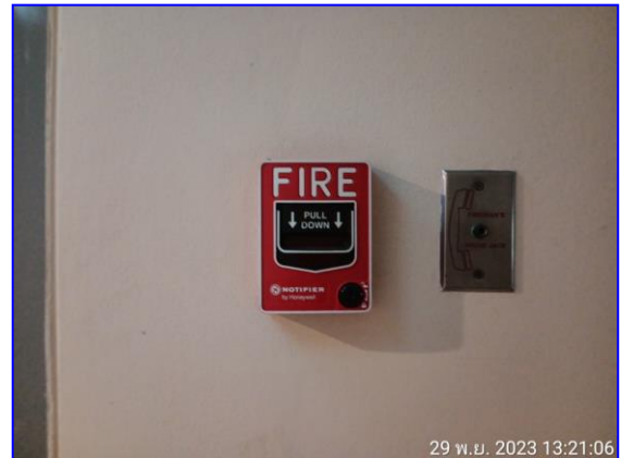
รูปที่ 2.44 สัญญาณแจ้งเตือนเหตุเพลิงไหม้
